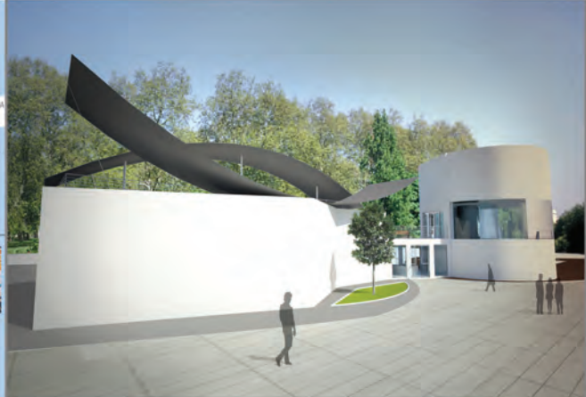
KEVLAR è un materiale straordinariamente robusto, leggero e resistente a taglio, la fibra munita dal marchio kevlar DuPont è estremamente resistente a taglio, all'abrasione ed alle temperature elevate. E' stato utilizzato per la realizzazione della copertura curva.
